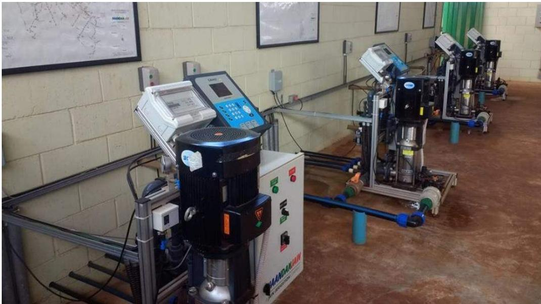
**Figura 12. Central de controle e monitoramento da irrigação e fertirrigação totalmente automatizada e digitalizada, instalado em sistema de irrigação por gotejamento subsuperficial em cultura de cana-de-açúcar para alta produtividade e redução de custos de produção, em operação em empresa do setor sucroenergético no noroeste do estado de São Paulo.**
