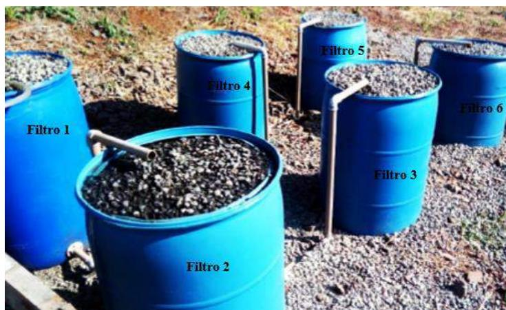
**Figura 10. Sistema de biofiltração composto por seis filtros anaeróbios verticais confeccionados em tambores plásticos (PITORO, 2019).**
