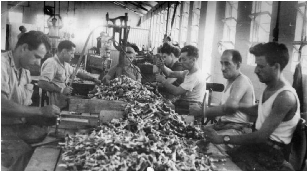
**Figura 1. Montagem de aspersores metálicos na fábrica situada no kibutz Naan, Israel, fundada no ano de 1937.**
